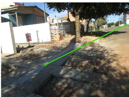
Piso Tátil instalado sem observar a continuidade do passeio. Percuso formado choca-se com uma árvore.
