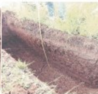
8. Lençol freático encontrado (1,70 m).
