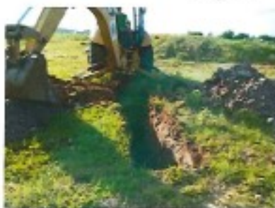
1. Trincheira com retroescavadeira.
