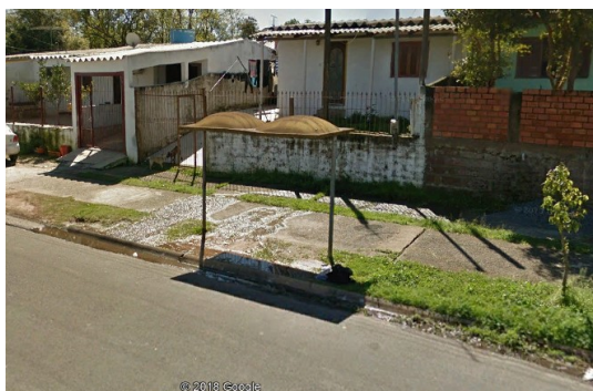
Abrigo antigo Rua Afonso Arinos
