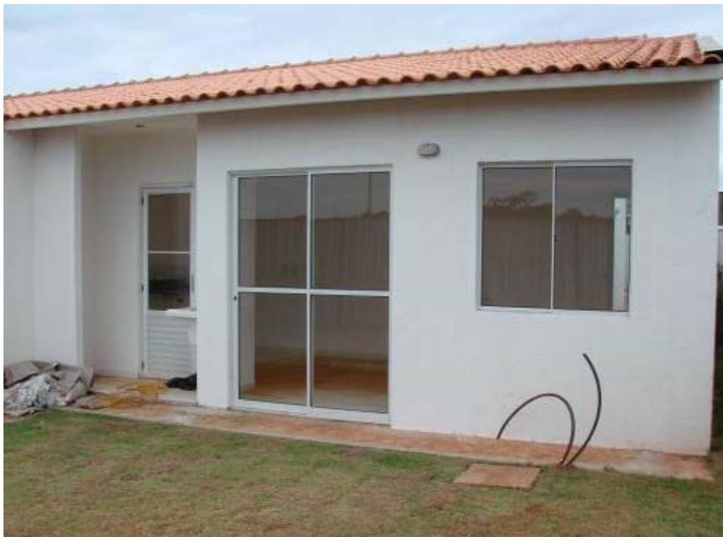
**Foto 2:** Fachada do ambiente “Estar/Jantar” utilizada para a determinação do isolamento ao ruído aéreo. Pode-se notar a grande área envidraçada sem proteção solar.
